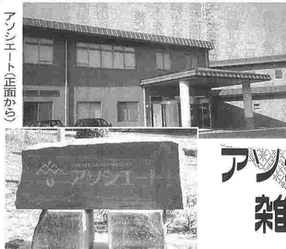
アソシエート（正面から）
